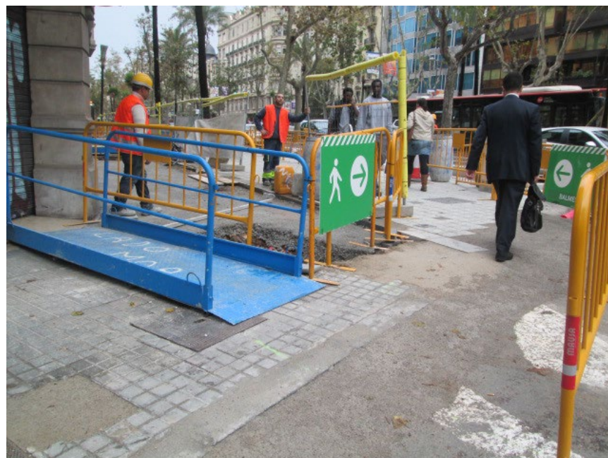
Imatge 3. Mostra de passera per a vianants destinada a permetre l'accés a façana.
