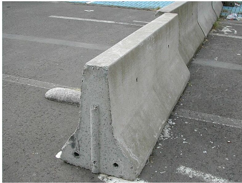
Imatge 6. Mostra de barrera doble New Jersey.
